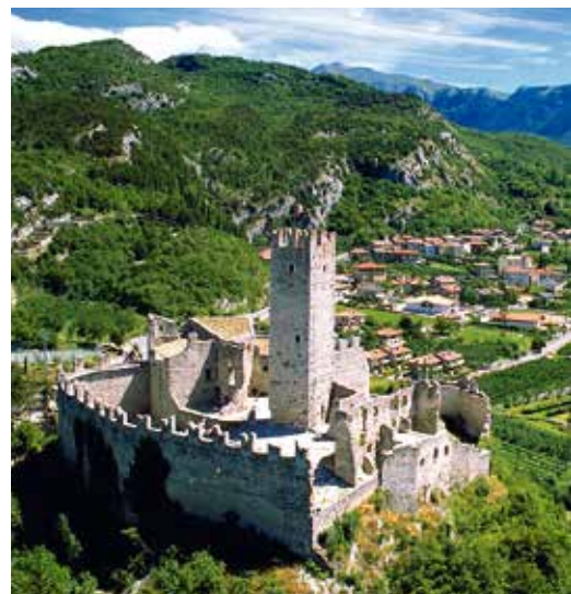
CASTELLO DI DRENA (Drena) • foto di Promovideo
